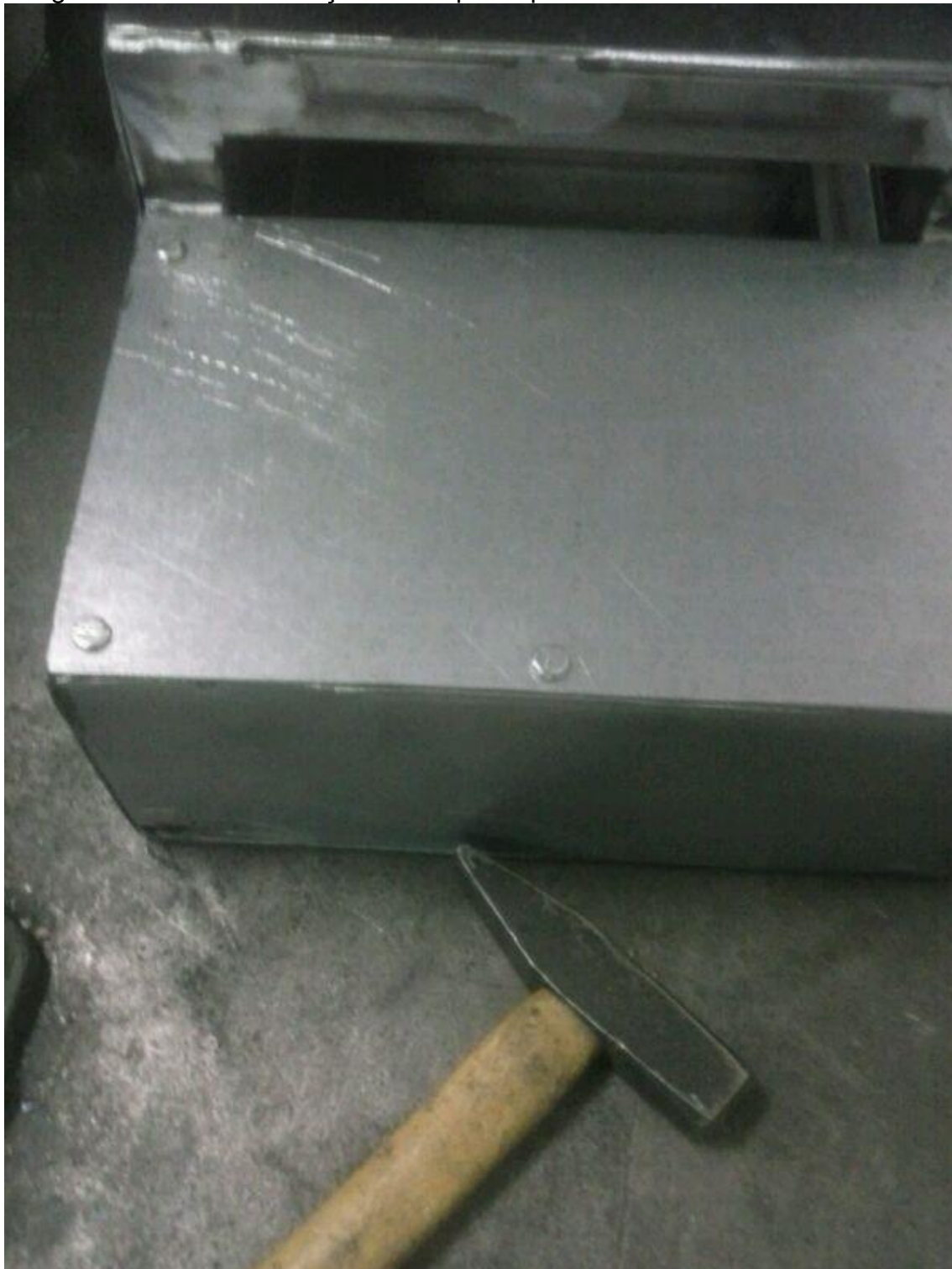
Figura 8. Montagem painel de acionamento.
